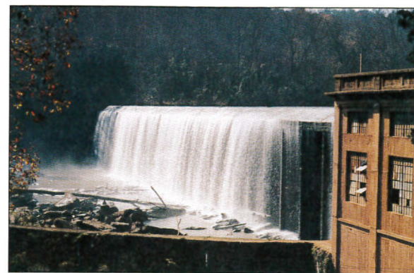
Bartletts Ferry Dam, Georgia, USA.
