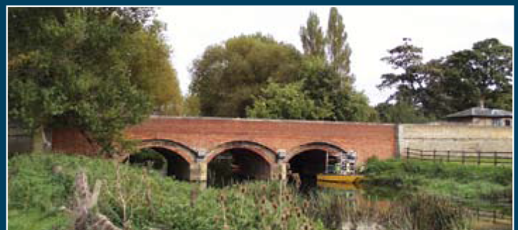
Middle Bridge, Newport Pagnell
