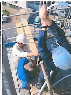
Mise en place d'un ancrage vertical
