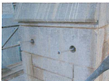
Ancrages horizontaux prêts pour l'injection
