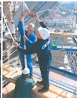
Mise en place d'un ancrage vertical
