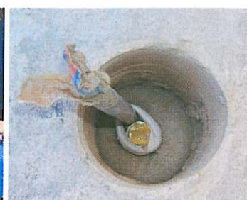
Ancrage vertical injecté
