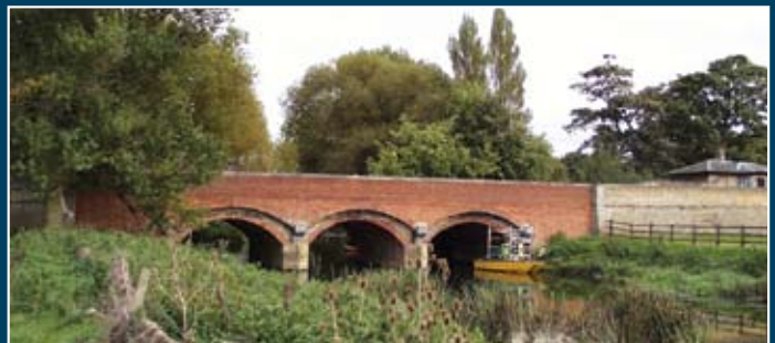
Middle Bridge, Newport Pagnell
