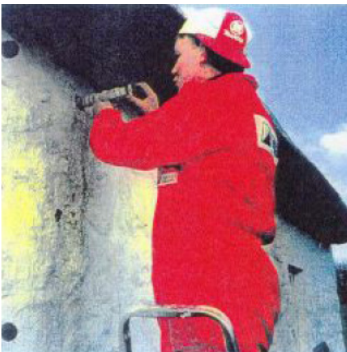
(d) Installing the anchor.
