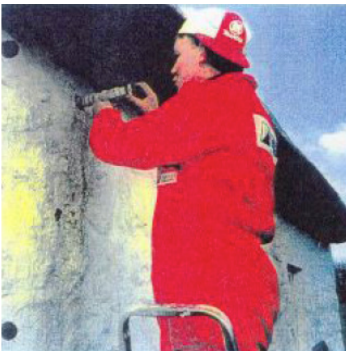
(d) Installing the anchor.
