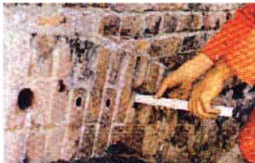
Posizionamento delle ancore nei fori
