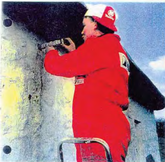
(d) Installing the anchor.
