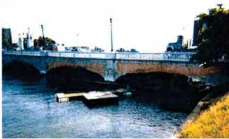
Puente Laguna Condado San Juan Puerto Rico
