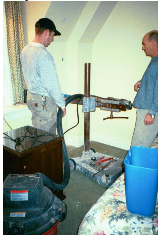
Poussière - forage directionnel libre
