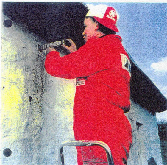
(d) Installing the anchor.
