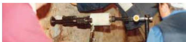
La resistenza a trazione e a taglio può essere verificata con prove di laboratorio o in sito.
