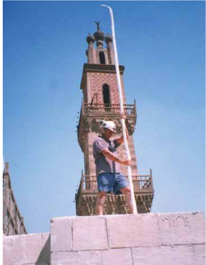
Moschea di al-Ghuri: installazione di un'ancora verticale lunga 5 metri in corrispondenza della copertura.
