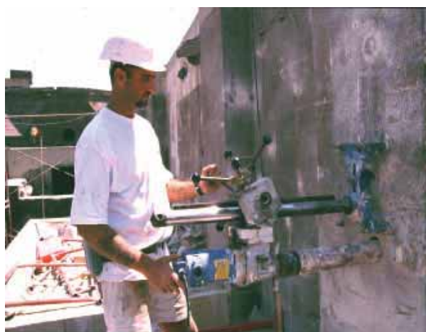
La tecnica di perforazione con funzionamento a sola rotazione permette, tramite l'estrazione di una carota, di creare la sede per il posizionamento dell'ancora.
